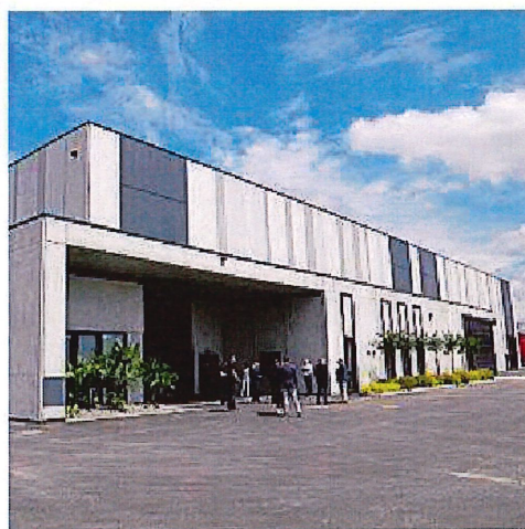
L'attività nel capannone ha preso il via a febbraio
